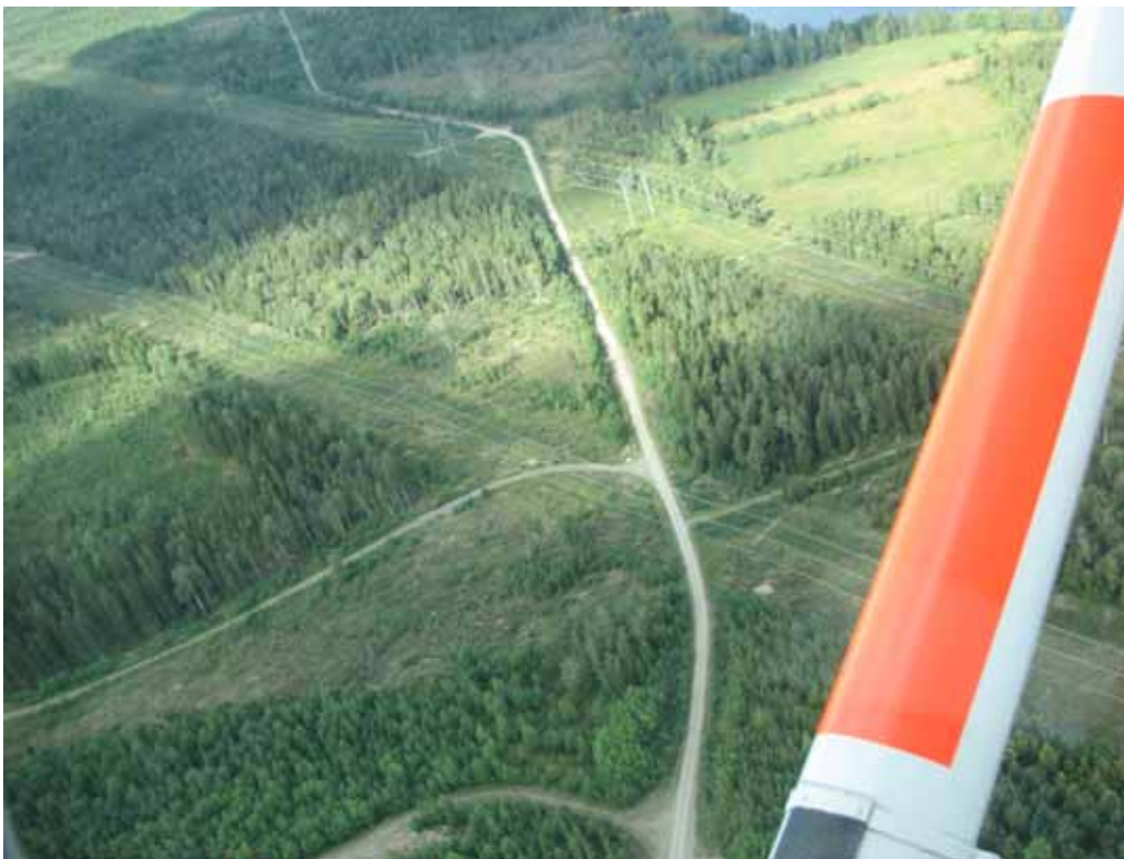
Översiktsbild av kraftledningar.
