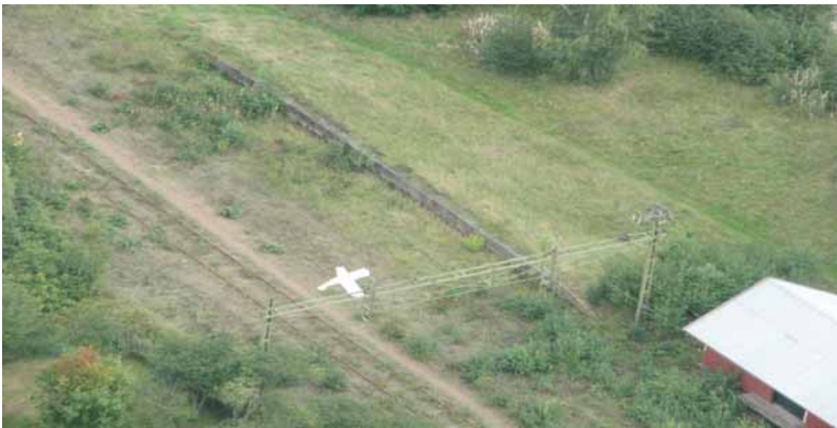
Skademarkering på järnväg
