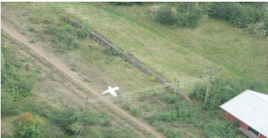
Bild från skademarkering på järnväg
